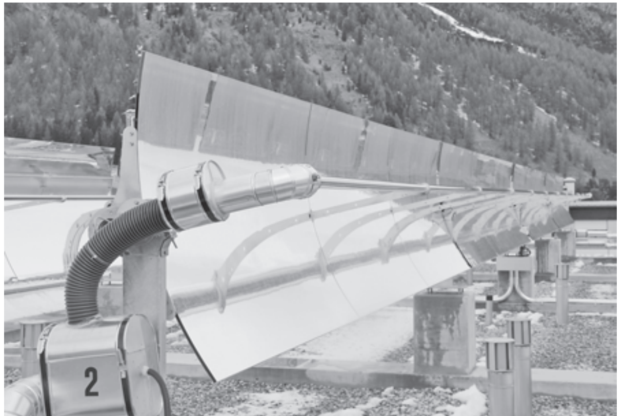
Sonnenkollektoren auf dem Dach der LESA: Sie sind Teil einer Anlage, die mit Sonnenenergie Dampf erzeugt.
